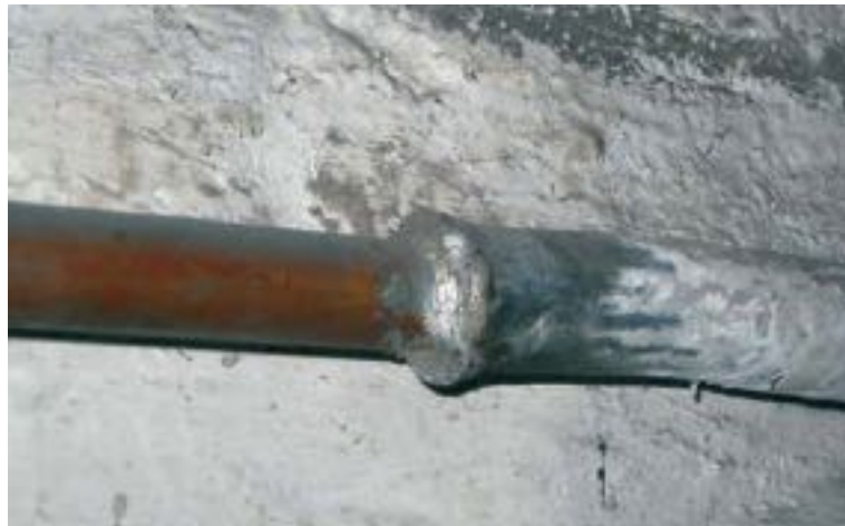
Sofern Trinkwasser fließt, müssen Bleileitungen bis Anfang 2026 ausgebaut oder stillgelegt werden. Foto: KBreker / CC BY 3.0
